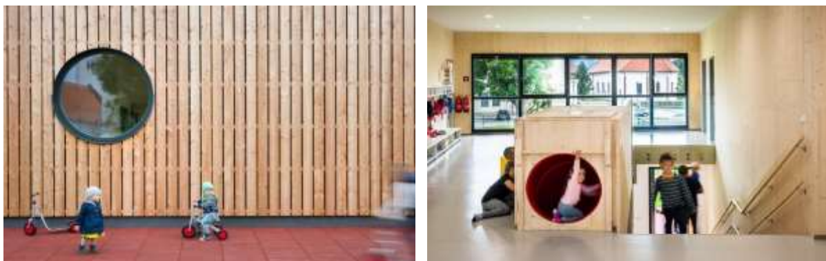
Figura 16 - Estrutura e Revestimento
