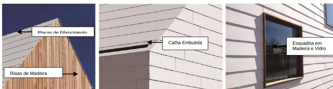
Figura 17 – Detalhes de Revestimentos.
