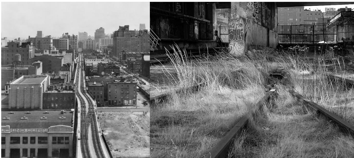
Figura 6 - À esquerda, linha ferroviária no período de funcionamento, à direita o local já abandonado.
