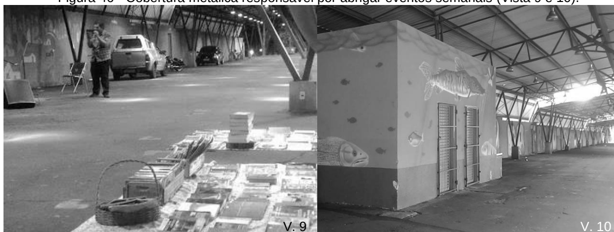
Figura 46 - Cobertura metálica responsável por abrigar eventos semanais (Vista 9 e 10).
