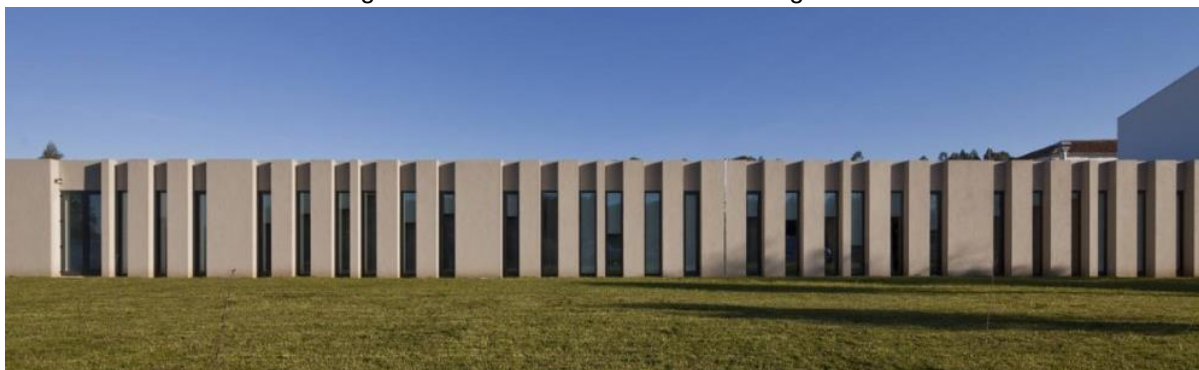
Figura 11: Fachada – Lar Casa de Magalhães.
