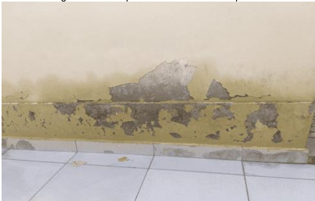
Figura 06: Exemplo de destacamento de pintura
