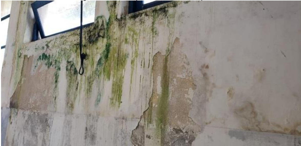
Figura 07: Exemplo de bolores na parede
