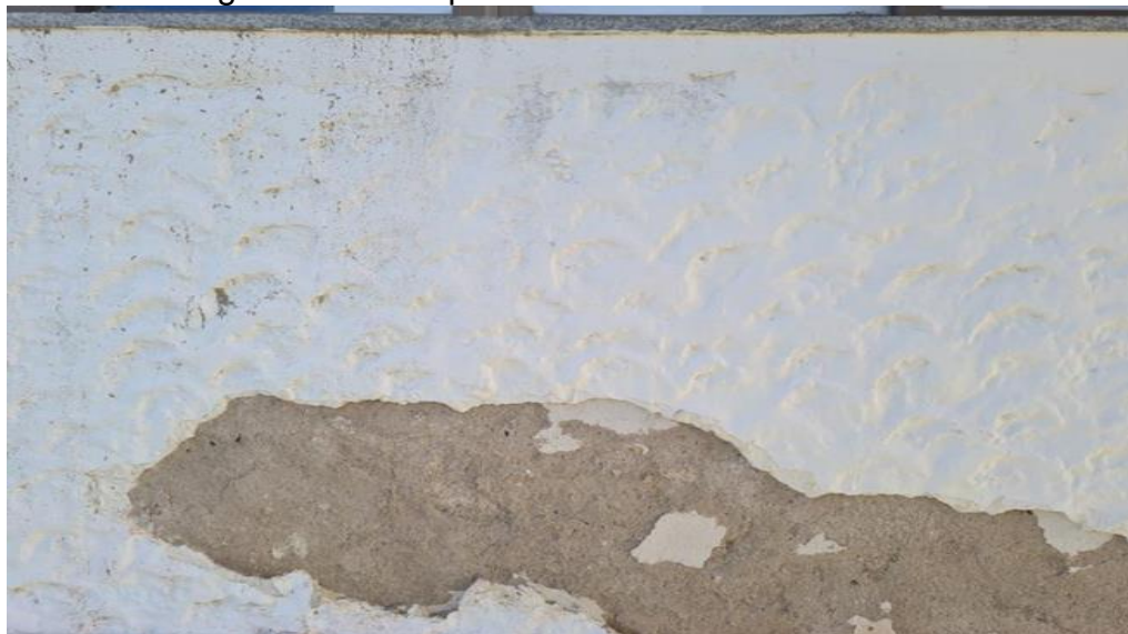
Figura 05: Exemplo de destacamento de reboco.
