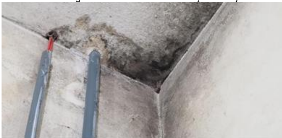
Figura 01: Umidade de infiltração na laje
