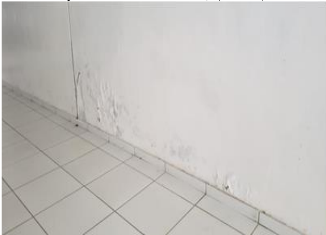
Figura 02: Umidade ascensional (capilaridade)
