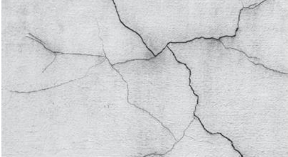
Figura 04: Exemplo de abertura em parede por dilatação térmica
