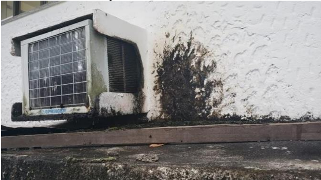
Figura 03: Umidade acidental
