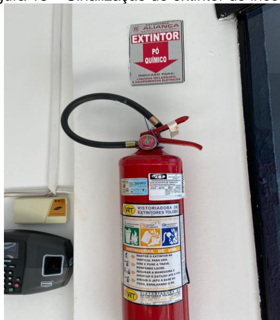
Figura 13 – Sinalização do extintor de incêndio
