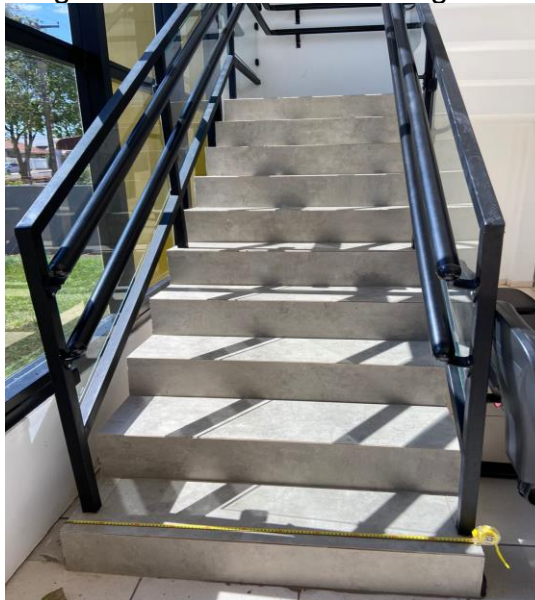
Figura 16 – Escada de emergência
