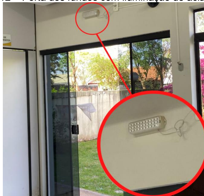
Figura 12 – Porta dos fundos com iluminação de aclaramento
