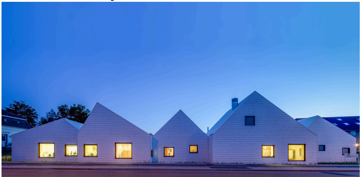
Figura 4 - Vista externa do Centro Livsum.
