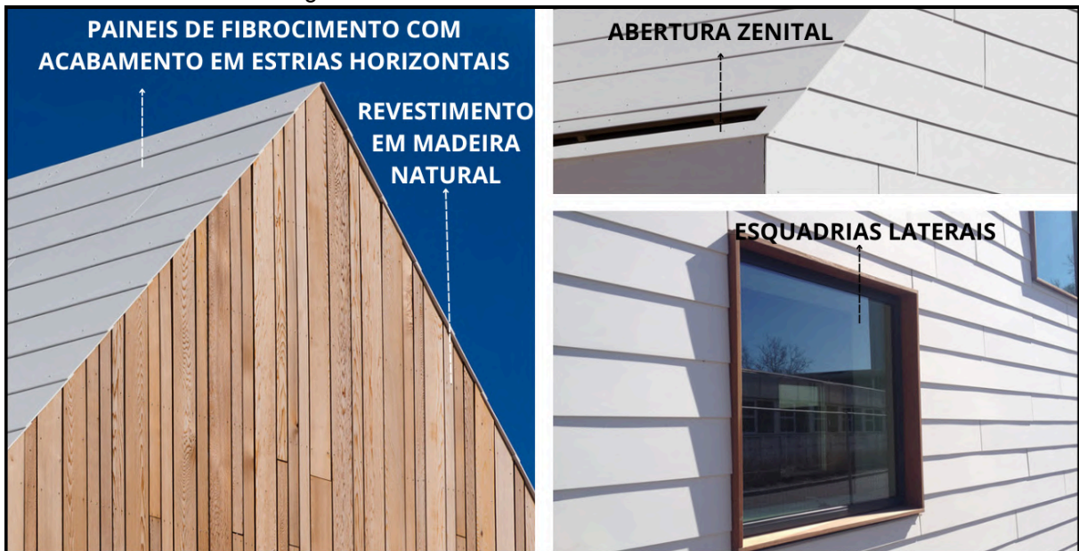
Figura 20 - Detalhes construtivos e de materiais.
