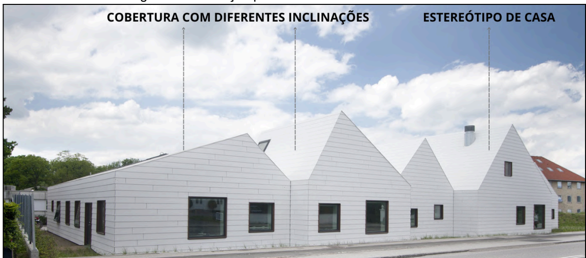
Figura 18 - Elevação posterior na via mais movimentada.
