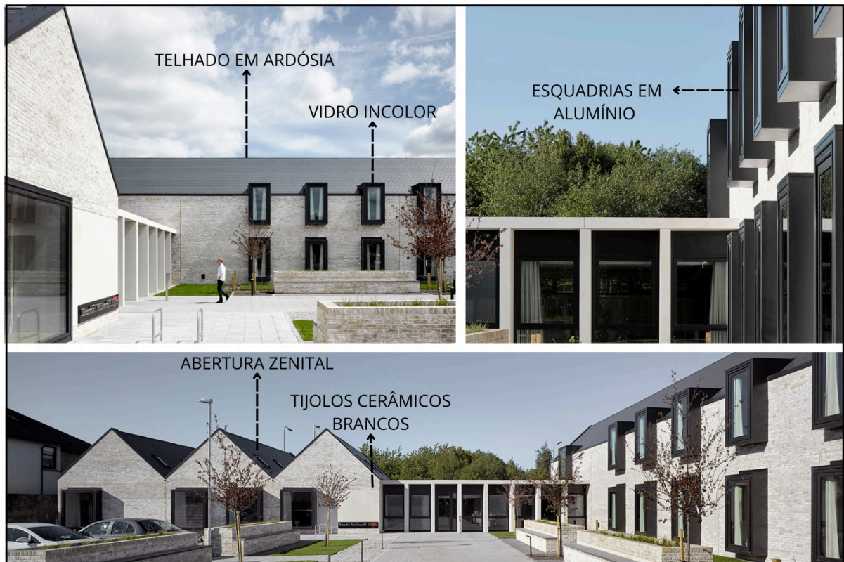
Figura 38 - Detalhes construtivos e de materiais.
