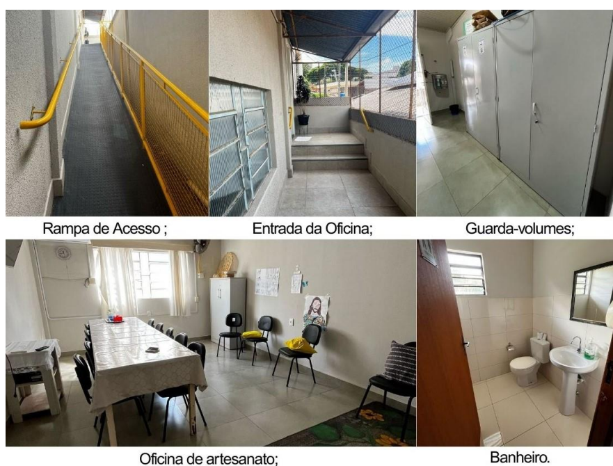
Figura 15 - Espaço de oficinas no 2º andar
