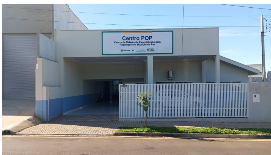
Figura 4 - Fachada da instituição
