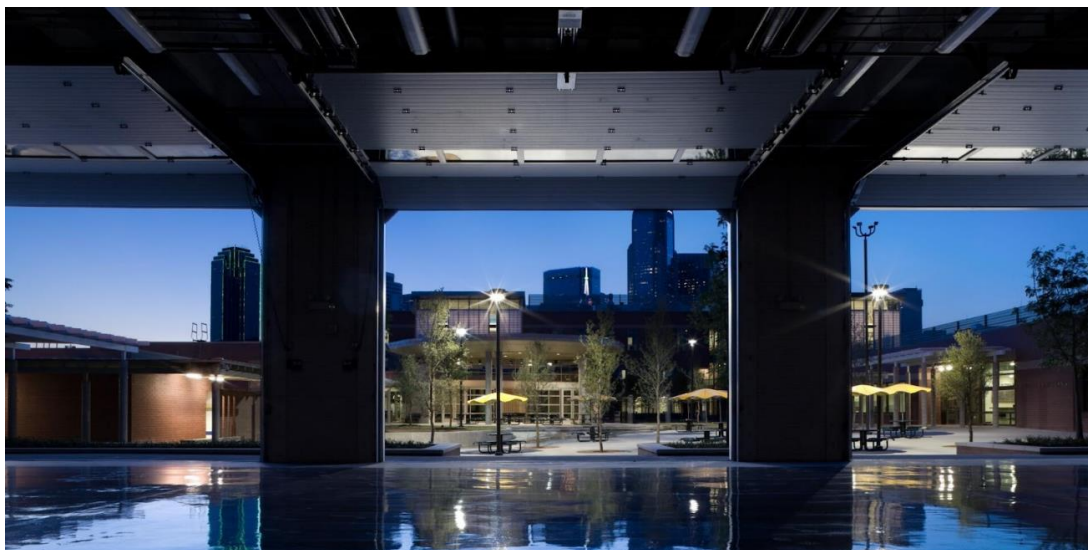
Figura 26 - Edifício Sono, vista interna
