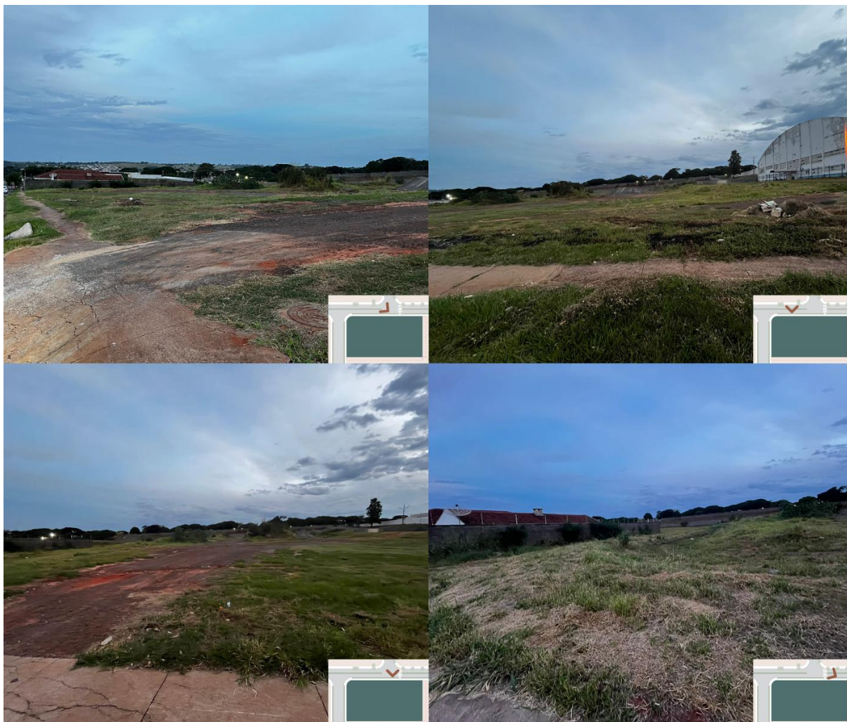
Figura 62 - Fotos do terreno
