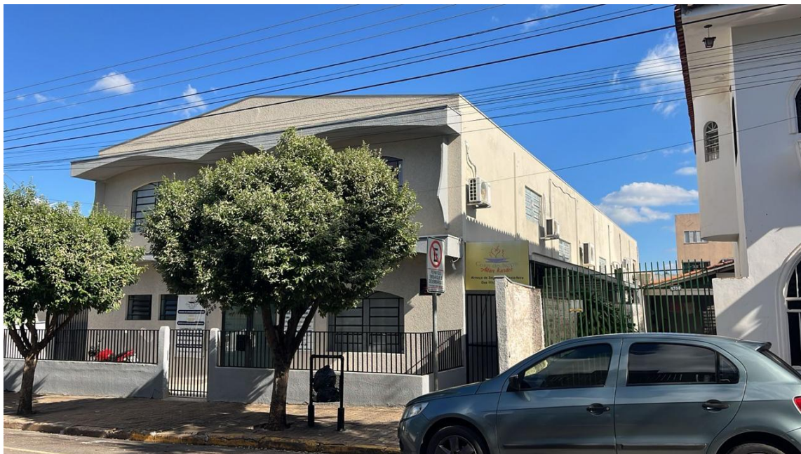
Figura 13 - Fachada da Casa da Sopa e Centro Espírita
