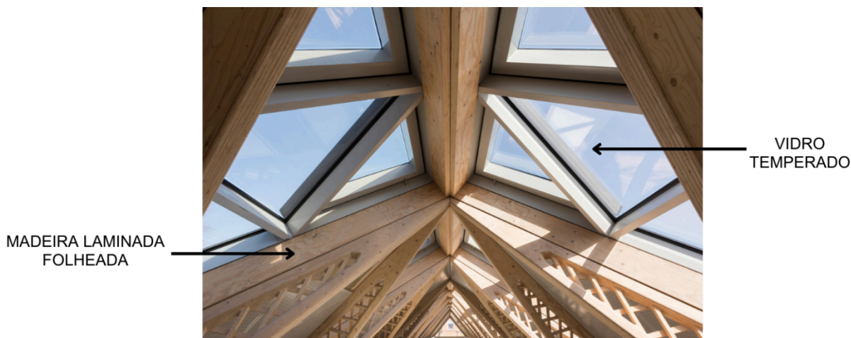
"Figura 16 - Estrutura clarabóias.
