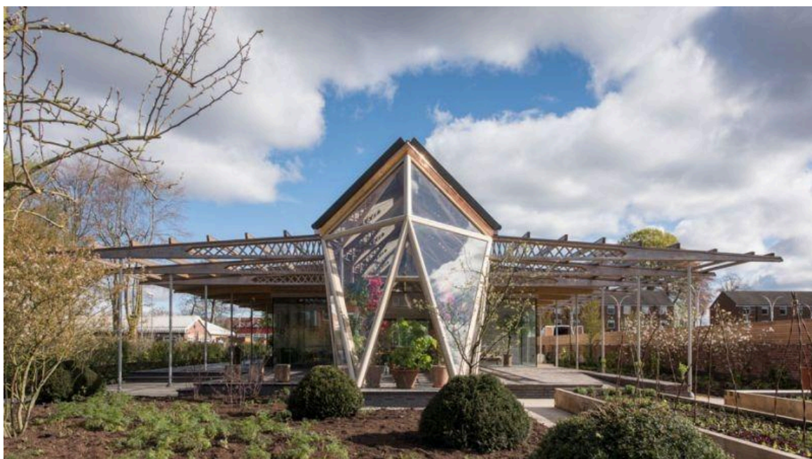
Figura 4 – Vista externa do Centro Maggie's
