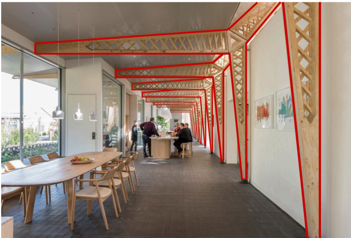
Figura 10 – Vigas estruturais atuando como divisórias.
