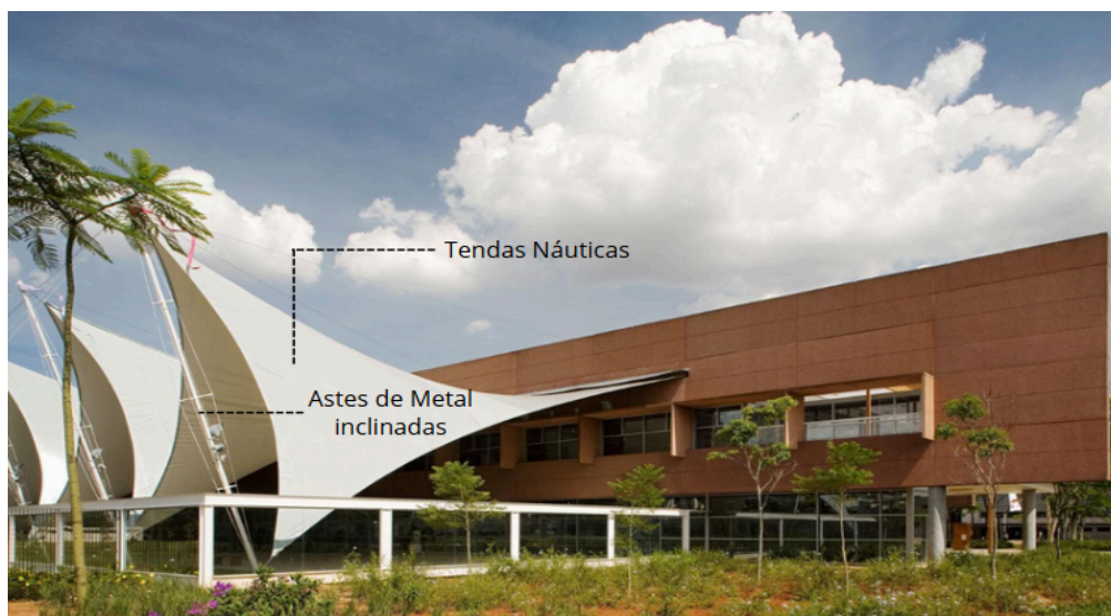
Figura 23: Terraço do Pavimento Térreo
