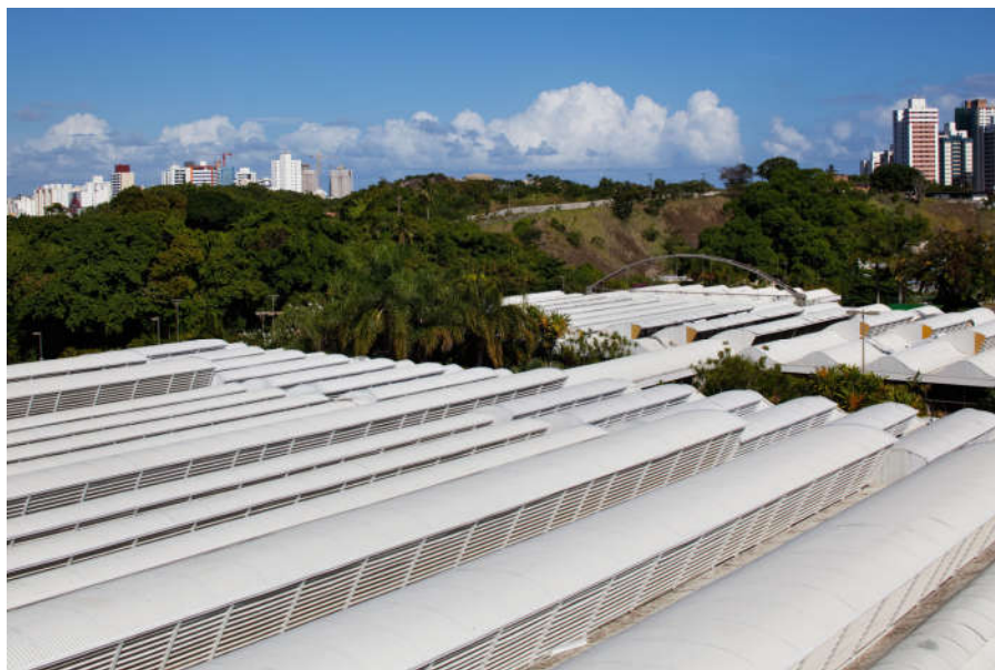
Figura 21: Ritmo da Cobertura de Sheds – Hospital Sarah Kubitscheck
