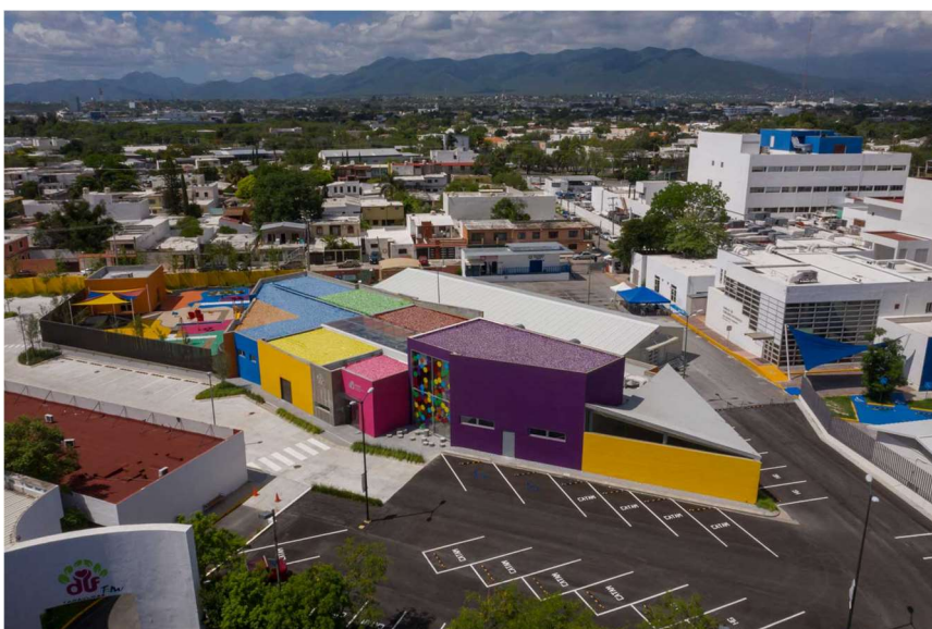
Figura 34: Vista aérea do CATAM
