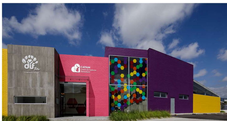
Figura 33: Vista da fachada principal do CATAM
