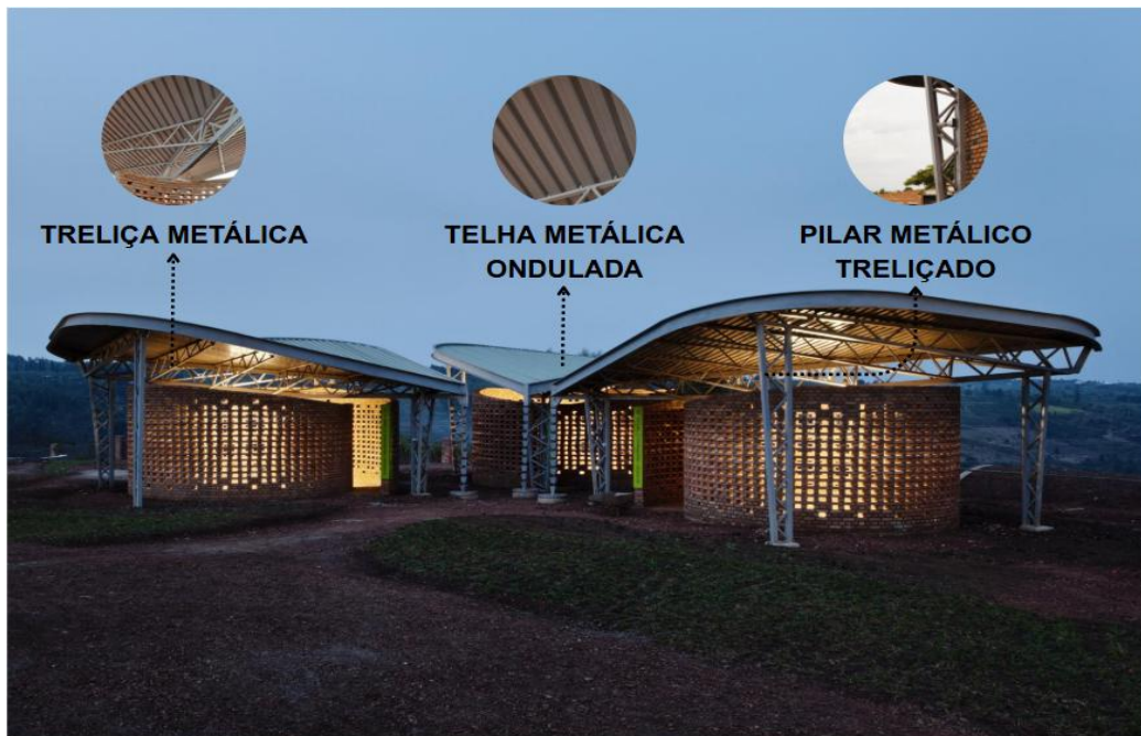
Figura 30 - Sistema construtivo da cobertura
