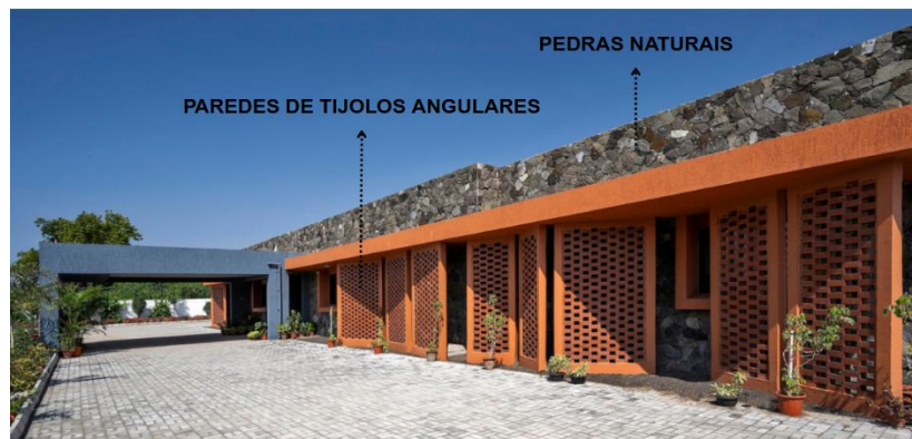
Figura 11 - Exterior com aplicação de pedras naturais e parede tijolos angulares
