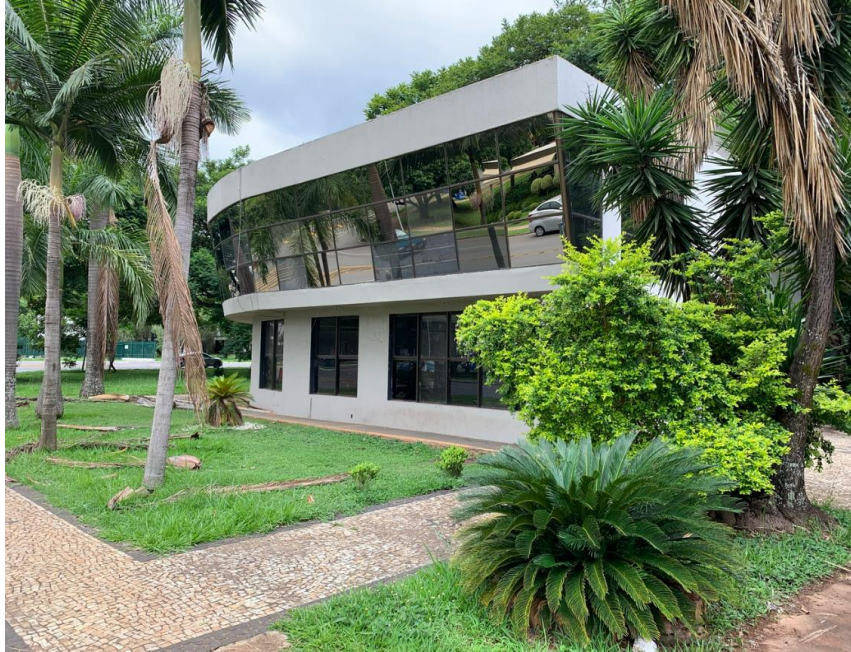
Figura 03 - Antes da adaptação
