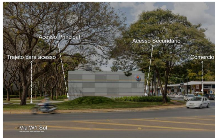
Figura 07 - Fachada Leste para Via W1 Sul
