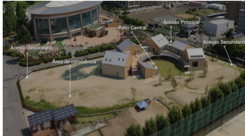
Figura 23 - Foto aérea da edificação.
