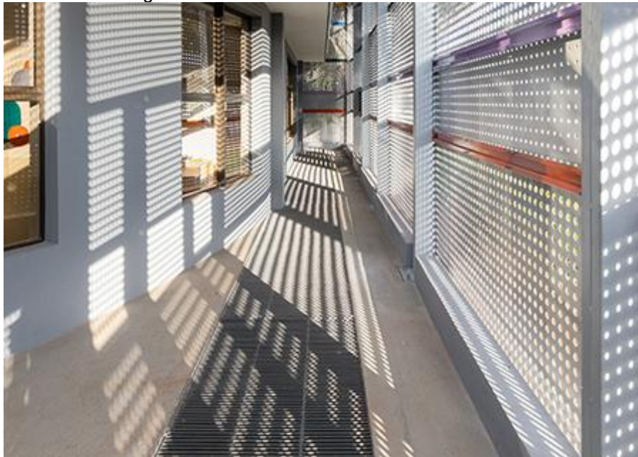
Figura 04 - Interior da estrutura metálica
