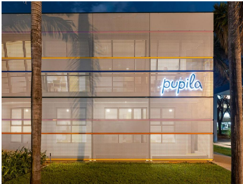
Figura 16 - Fachada para Via CLS 111/112
