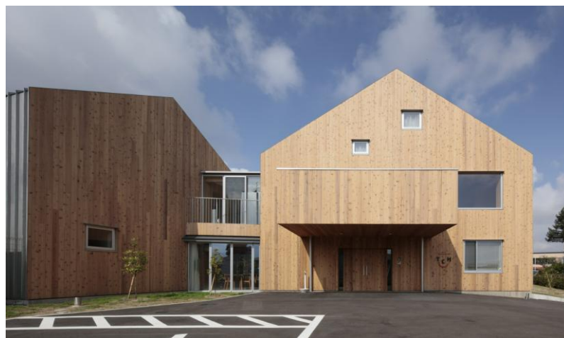
Figura 24 - Acesso Principal Hospital Psiquiátrico Tsurumi
